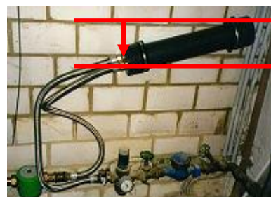
Montage incliné possible, avec les branchements toujours vers le bas
